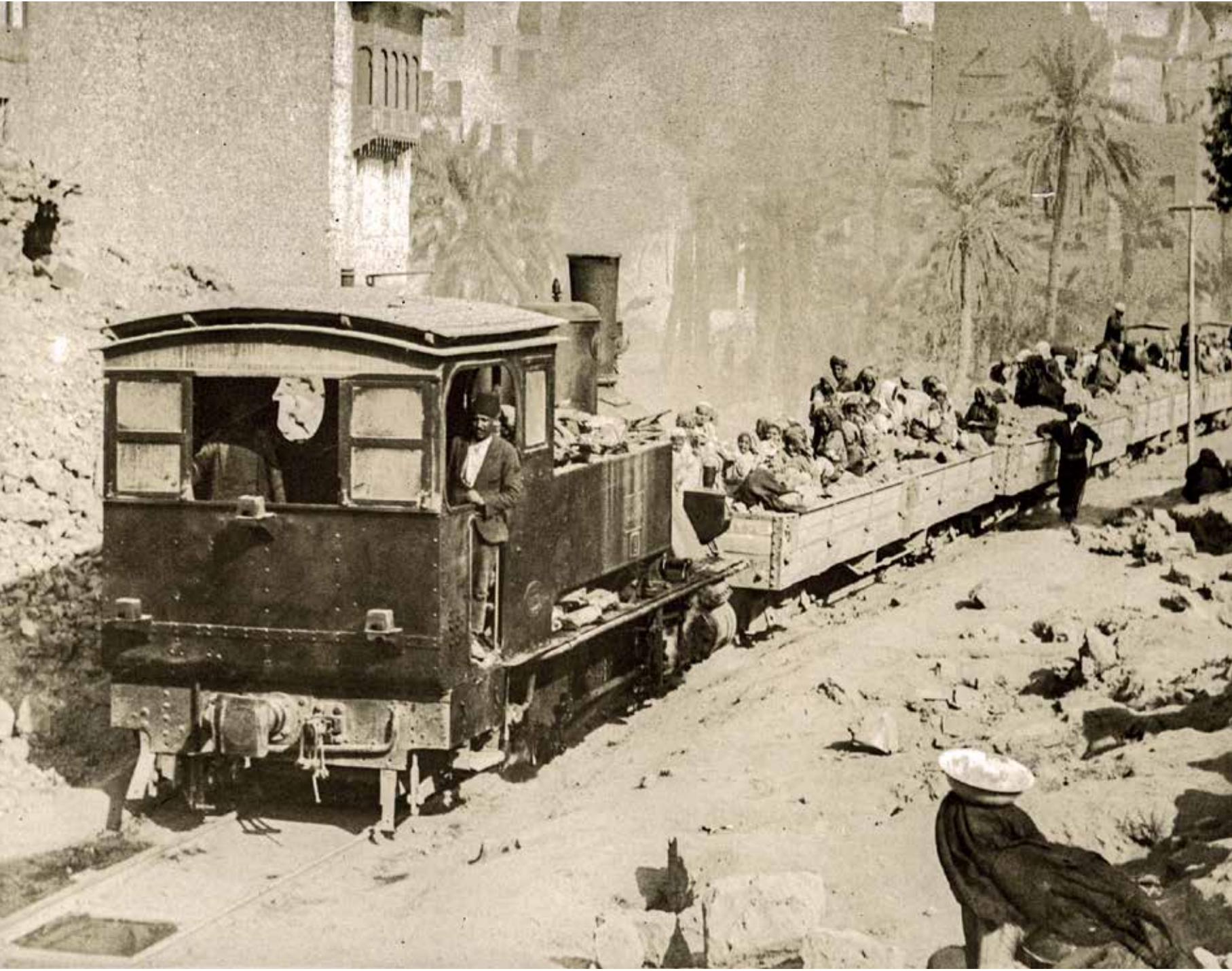
Babü's-Selam'dan Menaha'ya açılan caddede, imar çalışmalarından çıkan enkaz, demiryolu ile taşınıyor.
