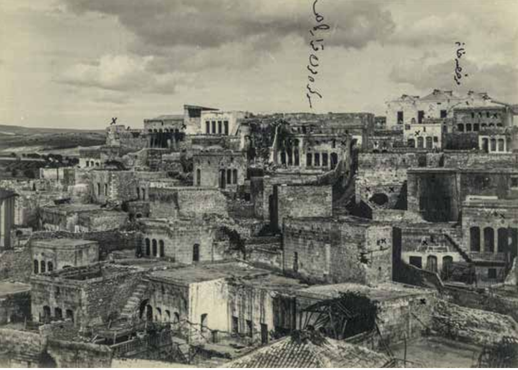
Urfa'da isyandan sonra Halilü'r-Rahman cephesinde Büyük Ermeni Kilisesi'ne çıkan bir sokak ve çevresindeki mahallenin tahkimatından kalan izler.
