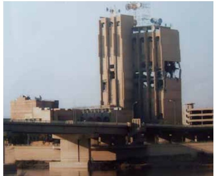
Irak Telekomünikasyon Binası Bombalandıktan Sonra / İlker Özkap
